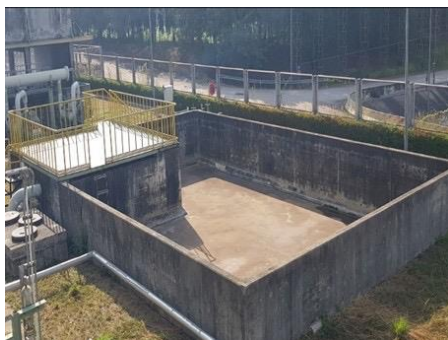
ภาพที่ 2-11 ถังเก็บสำรอง (Emergency Tank)
